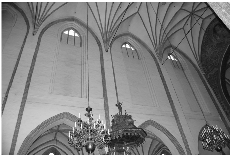
Ryc. 4. Kościół Narodzenia Najświętszej Marii Panny w Darłowie. Ściana północna nawy głównej. Fot. J. Kowalczyk-Kontowska, 2012 rok
